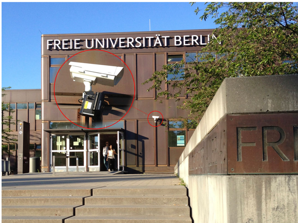
BLICK AUF DEN HAUPTINGANG DER ROSTLAUBE MIT VIDEOKAMERA AN FASSADE
